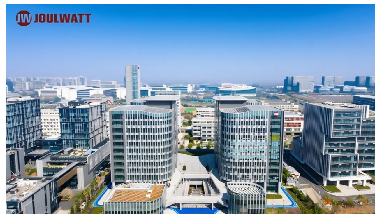
新辦公樓屋頂光伏投運
