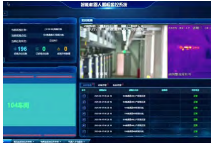
运用挂轨巡检机器人：整流柜表计自动巡检系统演示
