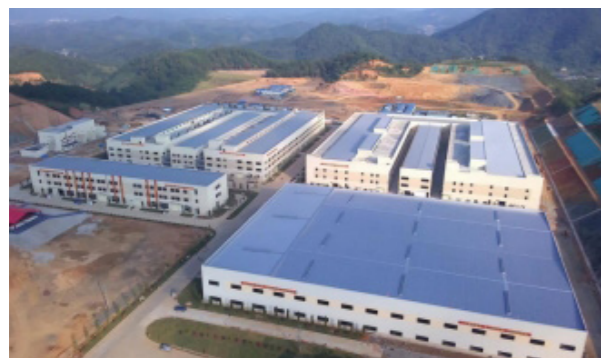
嘉元时代 10.88 兆瓦光伏建设项目
