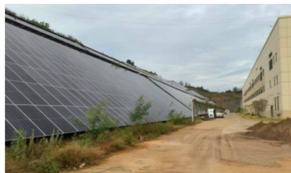
嘉元时代 6 兆瓦边坡光伏建设项目
