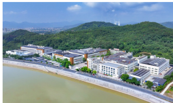
雁洋总部 6.57 兆瓦光伏建设项目
