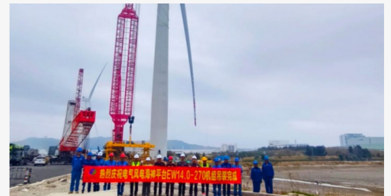
海神平台 EW14.0-270 机组吊装完成
