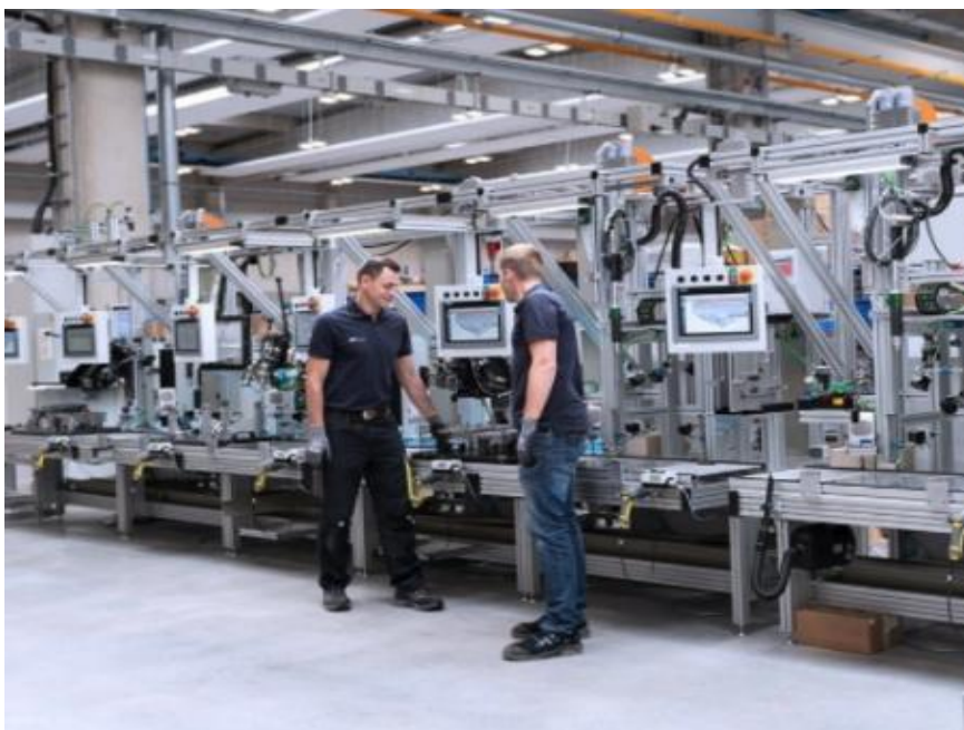
图：800V 变压测试系统
