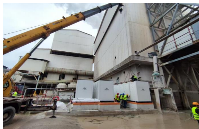
▲ 图为广东省佛山市某储能项目储能柜吊装照片
