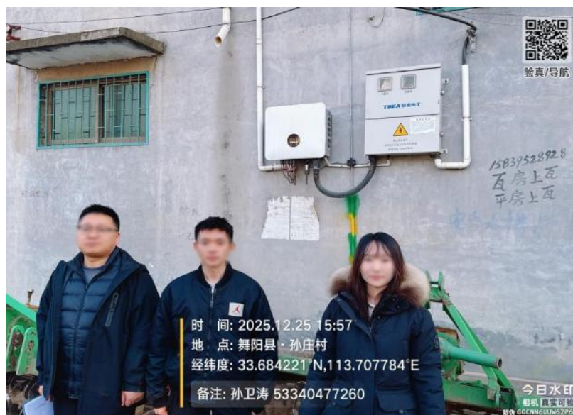
图 1 项目组现场盘点
