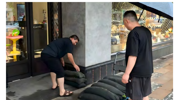
上海妇女用品商店通过放置防汛沙袋，杜绝积水等情况
