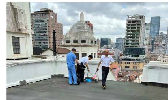
上海时装商店对天台、排水沟等关键区域进行清理检查
