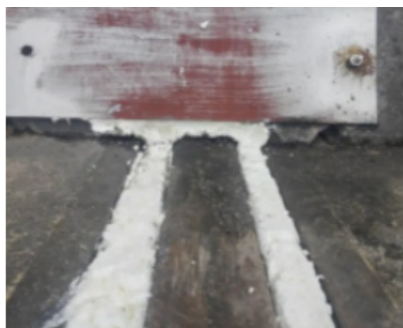
膨胀型聚氨酯伸缩缝快速封堵技术
