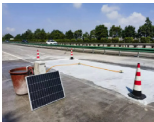
水泥混凝土路面破碎板智能养生系统
