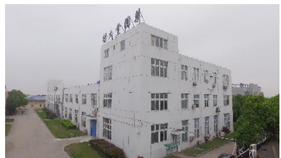
上海德大堂国药生产基地
