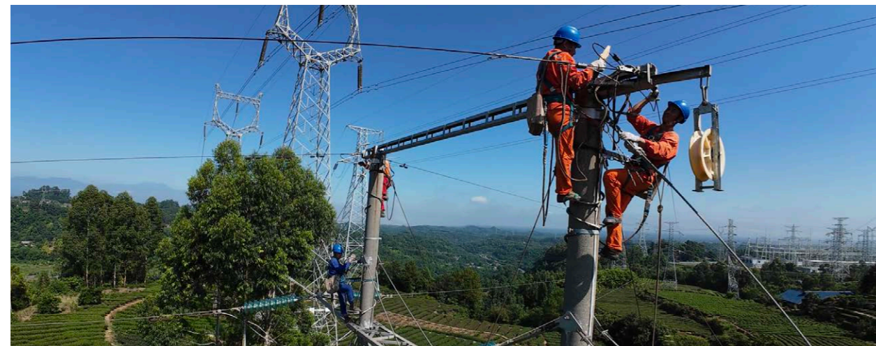
110千伏凤桐线架空地线更换，消除安全隐患，保障稳定可靠供电
