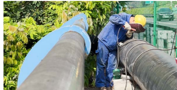
乐自高速供水管道工程
