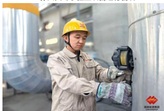
维修人员正在检查管道盲板阀
