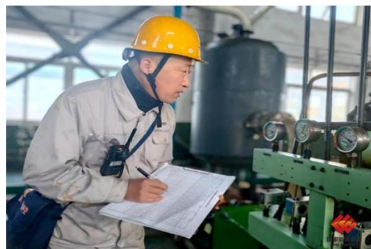
操作人员正在检查记录循环水供水压力
