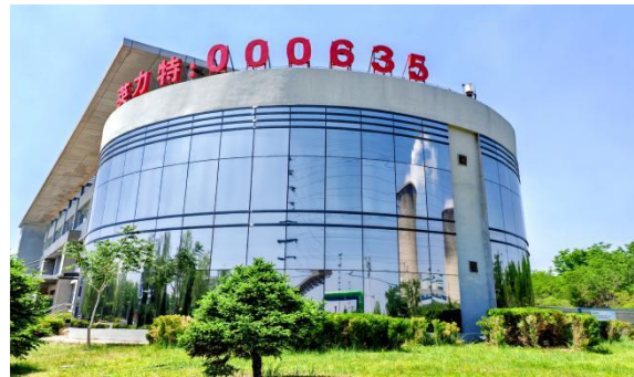
氯碱运行部集控室外观
