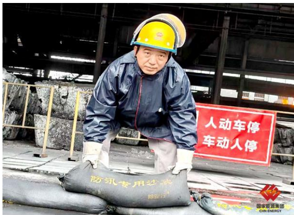
职工正在用防汛沙袋垒筑防水堤
