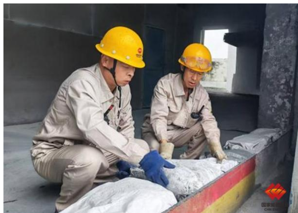
职工正在用防洪沙袋围堵电石库房大门
