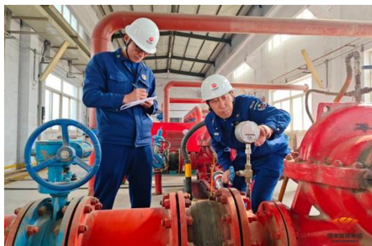
消防队员正在对消防水泵进行隐患排查
