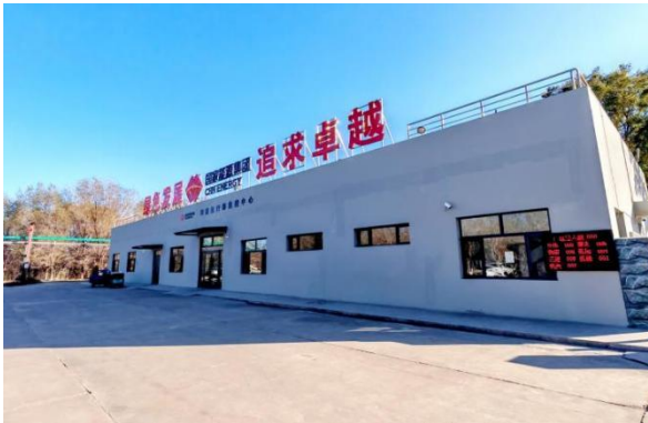
树脂运行部集控室外观
