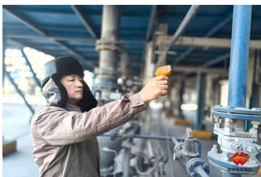
维修人员测量除尘净化系统管道温度
