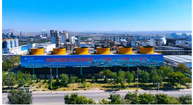
树脂运行部生产厂区
