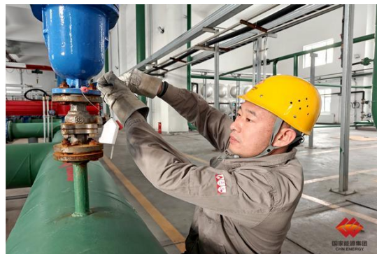
班组巡检人员巡检循环水设备运行情况
