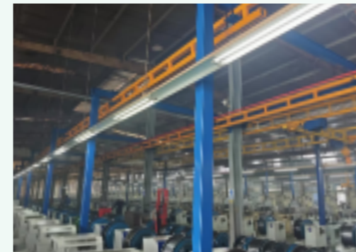
生产区域照明节能技术改造
