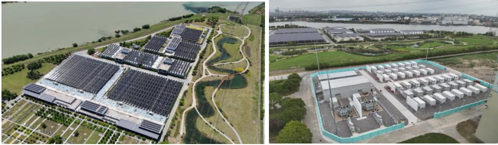
图：苏州规模最大的“光伏+污水处理”项目（左）、苏州新能 50MW/100MWh 储能项目（右）
