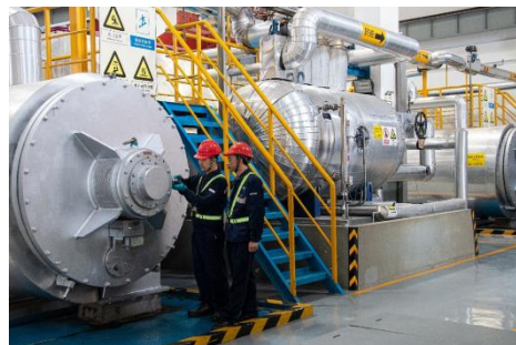
图：污泥处置项目车间
