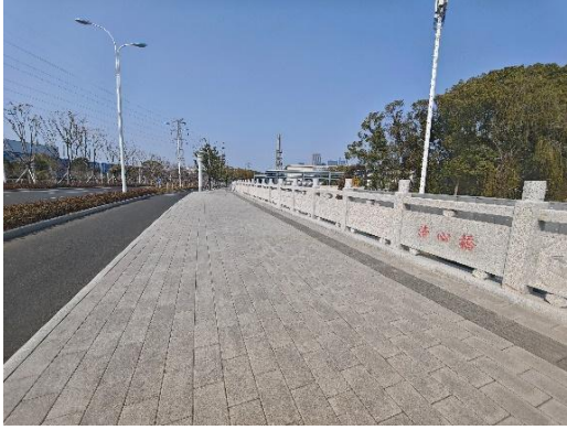
图：苏州工业园区星明街透水人行路面
