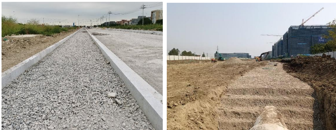
图：中新嘉善市政道路人行道垫层、雨污管道采用再生碎石回填
