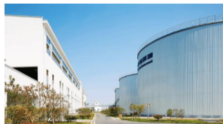
图：餐厨垃圾处理厌氧发酵罐
