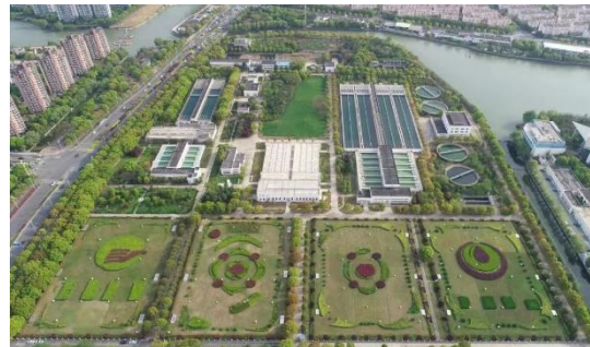
图：取水太湖的自来水厂（星港街）供水能力 45 万吨/日
