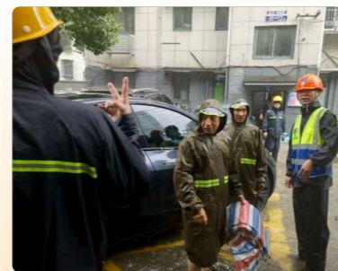
建工建乐参与老旧小区排水
