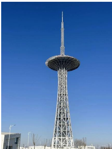
国际领先：重型偏心曲线造型 高精度信号发射塔（电视塔）
