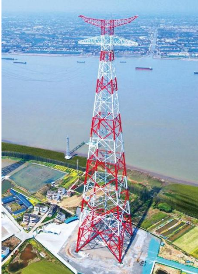
凤城—梅里 500 千伏线路工程 385 米长江大跨越高塔
