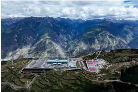
金上一湖北±800 千伏特高压直流输电工程
