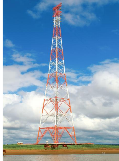
500 千伏巴西跨亚马逊河 296 米电力高塔
