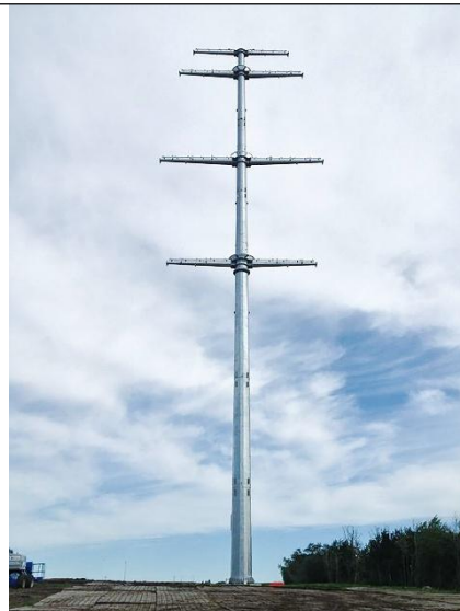
加拿大埃德蒙顿 500 千伏钢管杆工程
