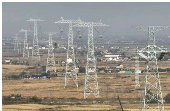
陕北—安徽±800 千伏特高压直流输电工程
