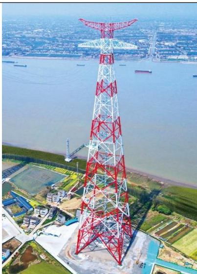
凤城—梅里 500 千伏线路工程 385 米长江大跨越高塔
