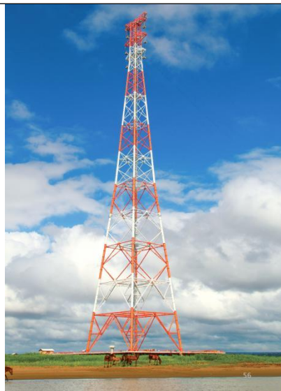
500 千伏巴西跨亚马逊河 296 米电力高塔
