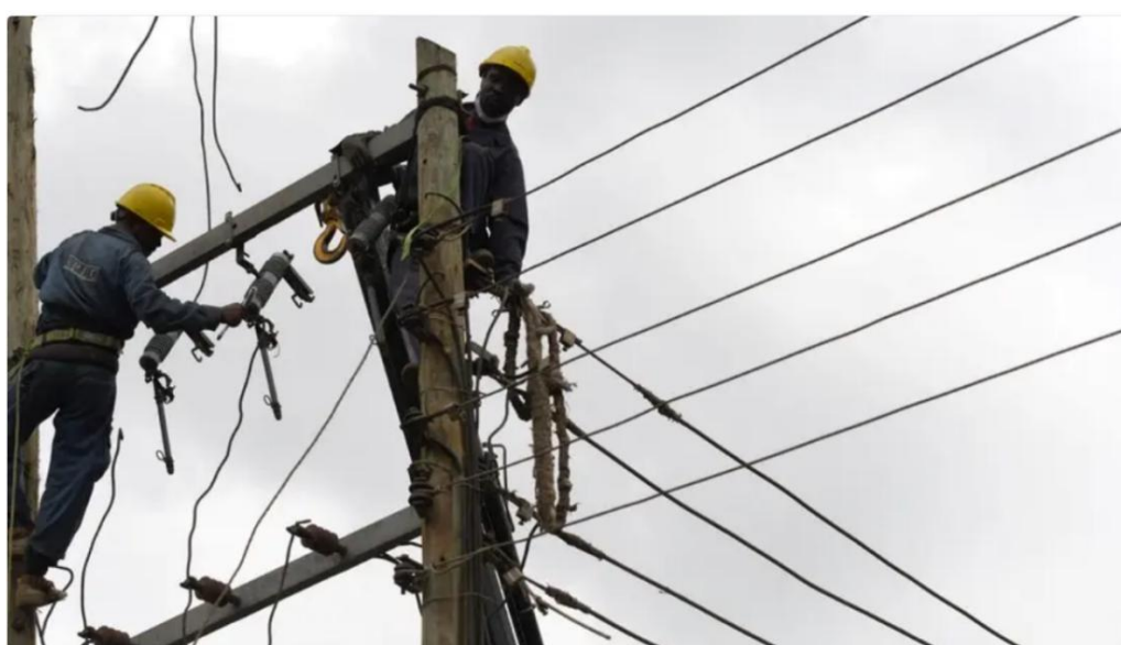
肯尼亚电力照明公司（KPLC）的工人在拆除电缆，以便迁移线路。（资料图片：法新社）
